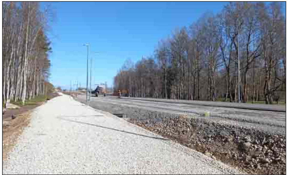
Дорожные работы на шоссе в первой половине мая.
